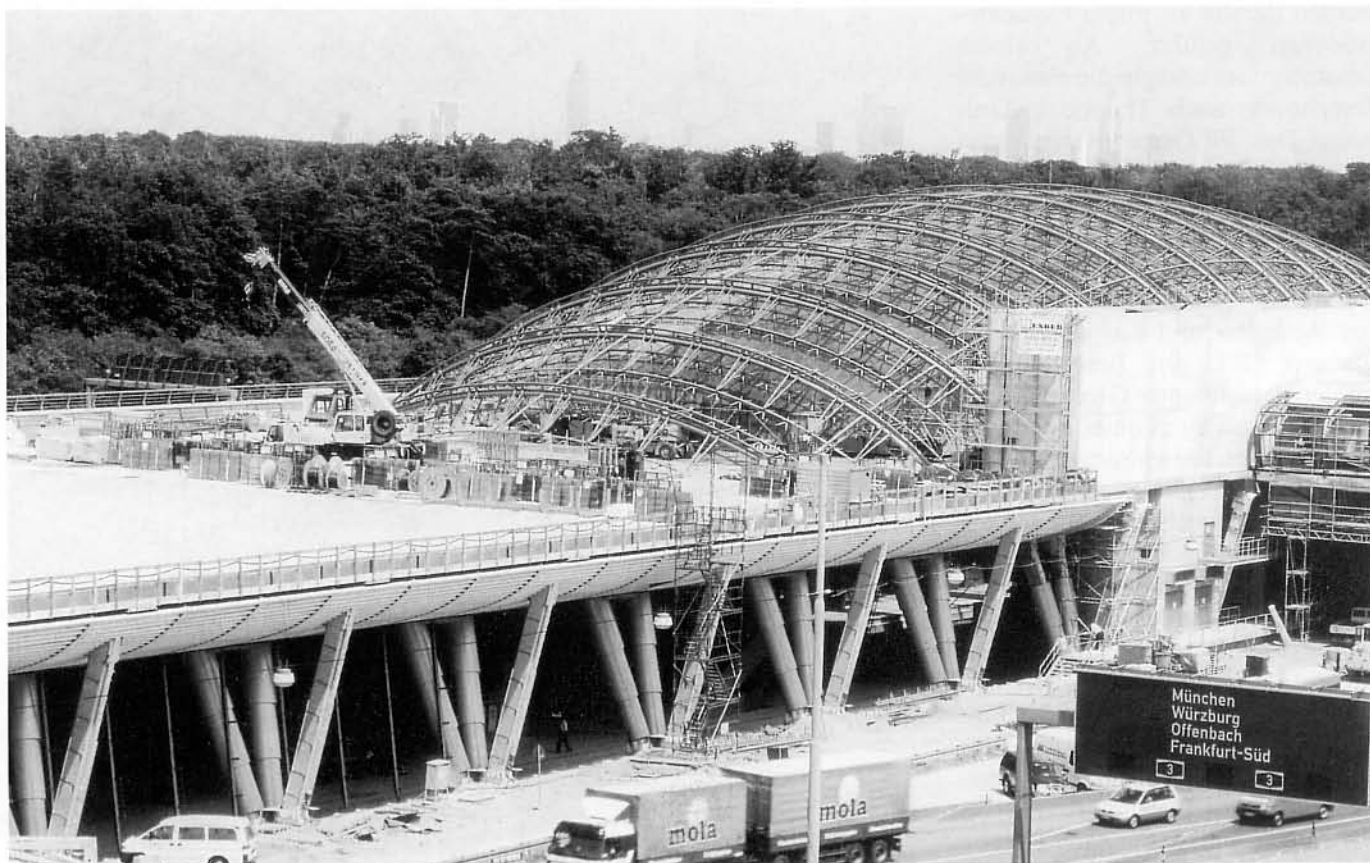
Bild 11. Blick auf die Baustelle
